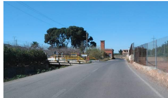
Acceso zonas industrial y de recreo desde Camí de Llíria
