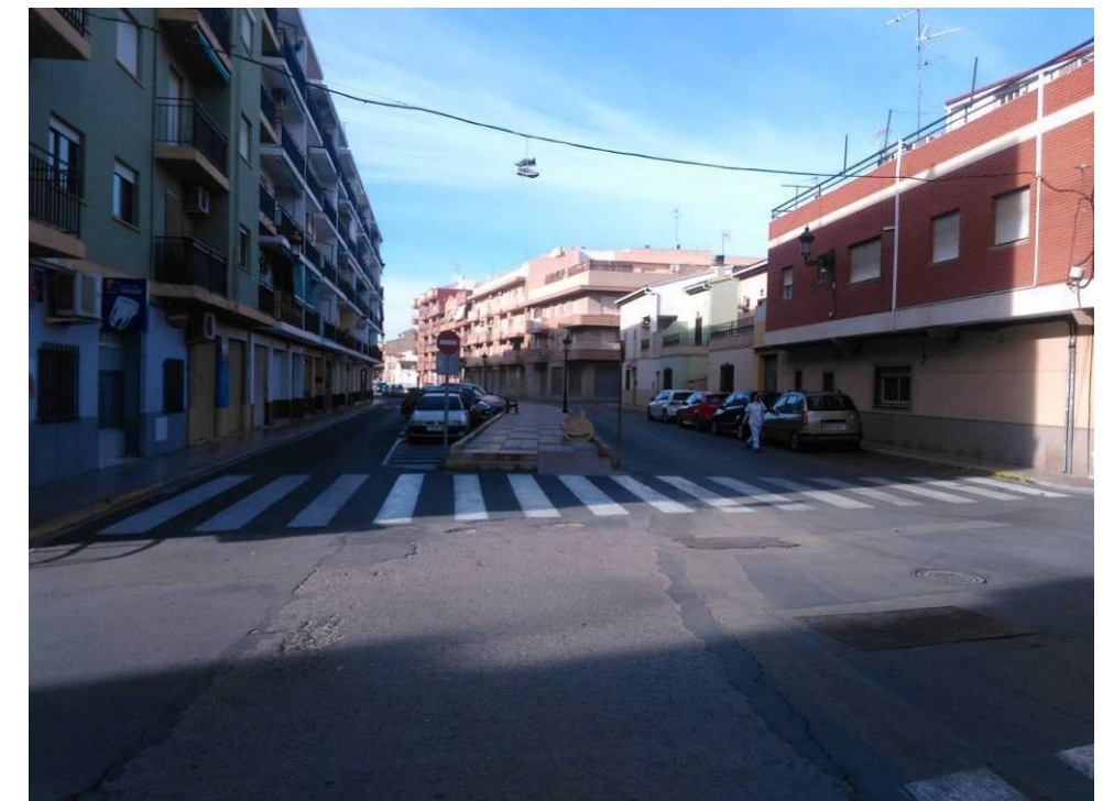
Calle Real Acequia de Moncada. Se aprecia el desnivel existente entre la acequia y las calzadas. Hay un tramo, en las proximidades del cruce con la calle Camí Fondo de esta calle limitado a velocidad 30
