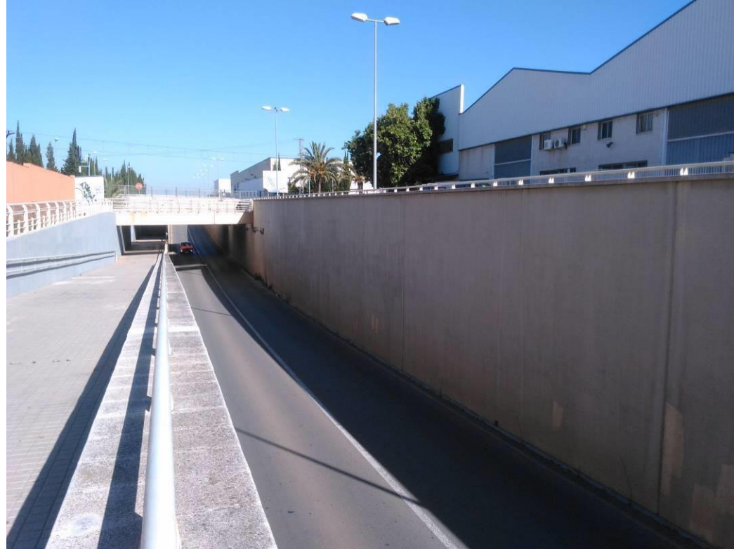
Paso inferior sur en el término municipal de La Pobra de Farnals.
