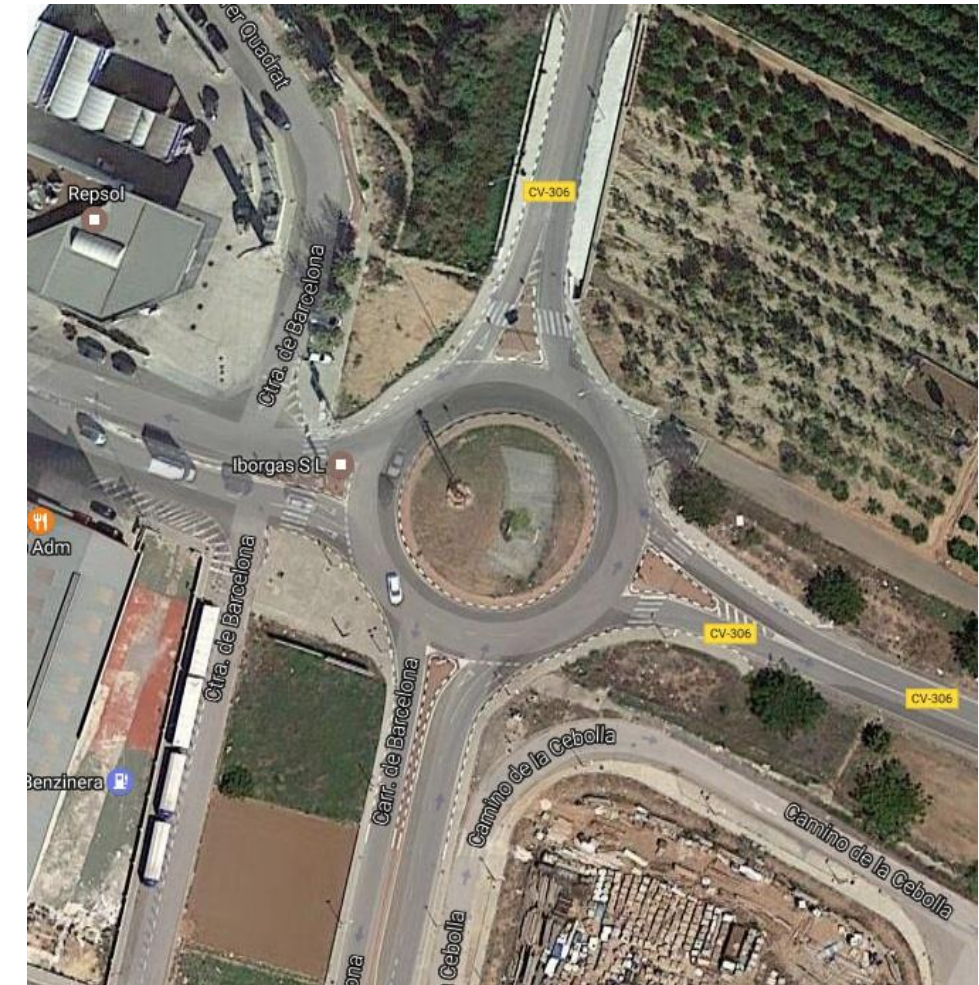
AFORO 1: Rotonda acceso desde CV-300.
