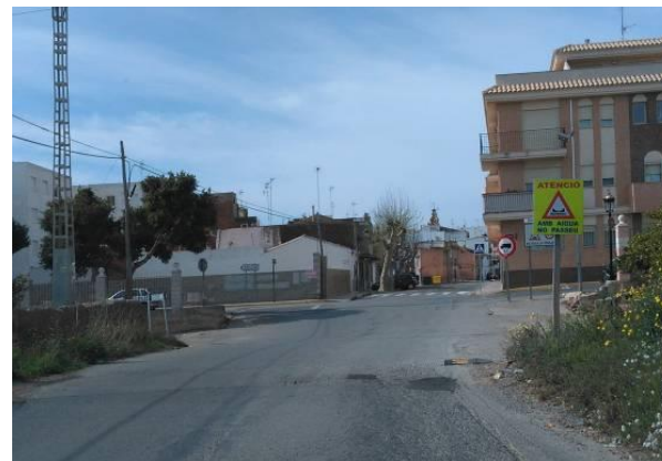
Badén acceso norte.
