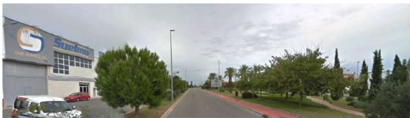
MOV2a | 2_Imagen de la carretera de Barcelona a su paso por Rafelbunyl y la imagen de un eje ajardinado de referencia en un polígono industrial de la Vall d'Uxó
