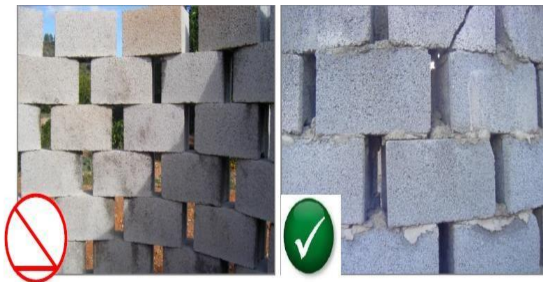
Foto 2. Construcción formada por bloques con y sin cemento de unión.
